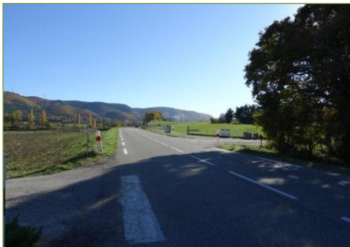
Photographie 25 - Route départementale n°2, au droit de la Levée, le 30 octobre 2015, point 24 sur la Figure 9 (source : Eco-Stratégie)
