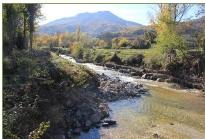
Photographie 23 - Le Rieutord, le 30 octobre 2015, point 22 sur la Figure 9 (source : Eco-Stratégie)
