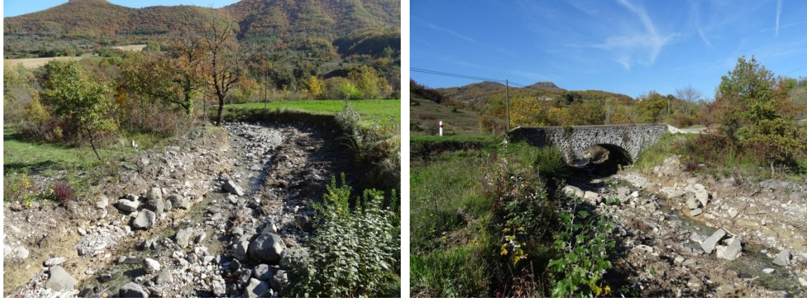
Photographie 1 et Photographie 2 - portions du Rieutord restaurées (pont à l'aval des Azinières)
