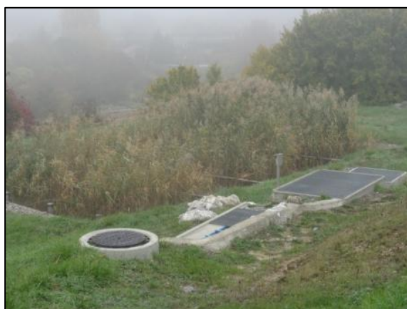
Photographie 27 et Photographie 28 – Station d'épuration de type filtre planté de roseaux du centre-village (gauche) et du secteur de Le Serre (Droite)
