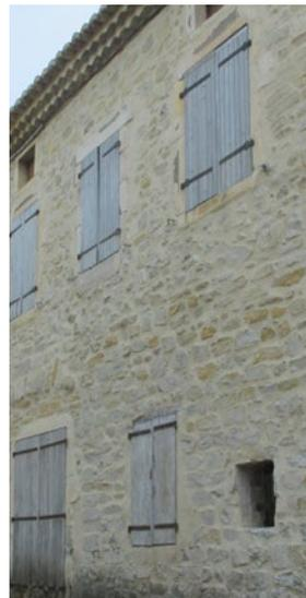
Village et Le Planas: jambage en calcaire et mur en basalte ou mixte calcaire-basalte
