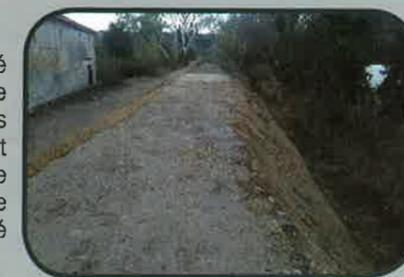
Des affaissements liés aux pluies de l'automne dernier ont nécessité des travaux d'urgence au droit de la ferme de St Hugues et du secteur de Beauchamp. La reprise de la digue avec la mise en place de gabions puis d'un remblaiement couche par couche s'est chiffrée à 115000 € TTC financés par le syndicat.
