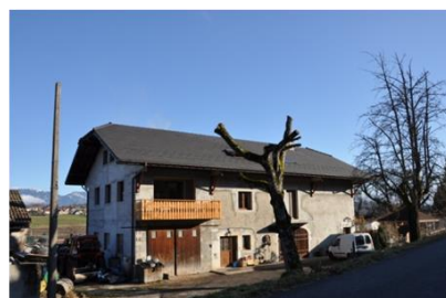
Menuiseries en ouverture de garage et en garde-corps
