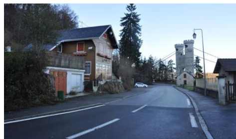
Le site des ponts de la Caille côté Allonzier...
