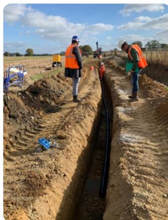
**2 -** Réalisation de la tranchée pour poser les canalisations destinées à acheminer les eaux usées à la station d'épuration
