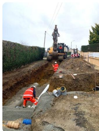
**6 -** Ensuite le chantier a continué vers la rue de la Pilonnière par la pose des canalisations et des branchements pour les eaux usées et l'eau potable.
