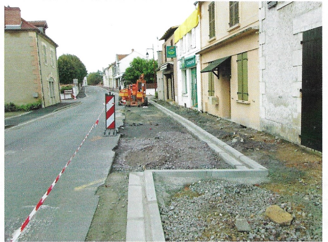
↳ La Grande Rue en travaux, les trottoirs se dessinent
