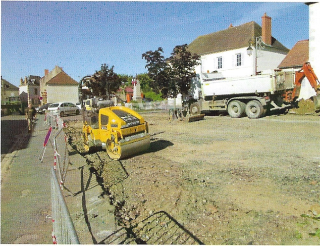
1 La place de la mairie en grand chantier
