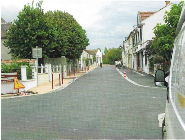
↳ Le chantier se termine
