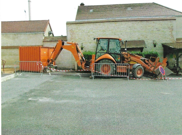
↳ Les premiers éléments du futur chantier se mettent en places.
