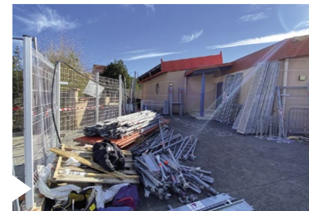
L'école maternelle en cours de rénovation / © G. Coudré
