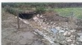
Restauration du lit mineur – affluent de la Verzée à Soudan
