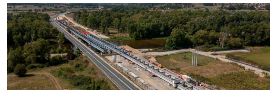
Pont sur l'Allier
