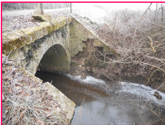
Vue du pont avant restauration.
