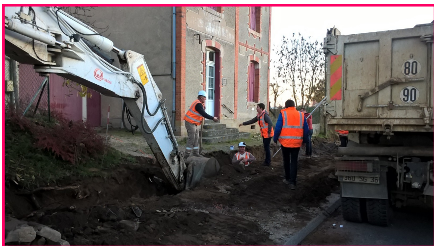
Chantier le long de RD 2009.
