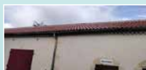
Toit Bâtiment annexe Mairie
