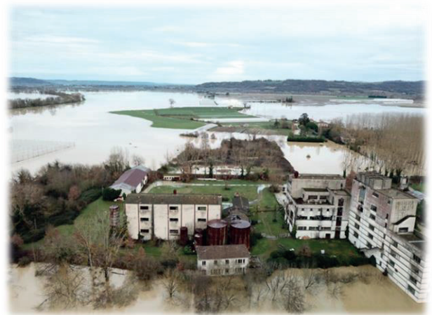
Plaine inondée, crue de février 2021-Photo : I.Caire
