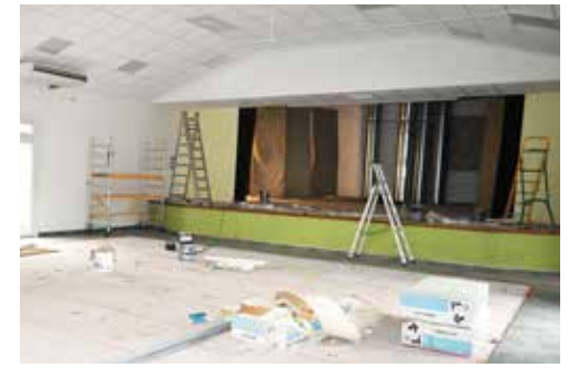
Actuellement en pleins travaux, la grande salle disposera d'une vaste scène et retrouvera un parquet de danse vitrifié pour sa réouverture, courant 2023.
