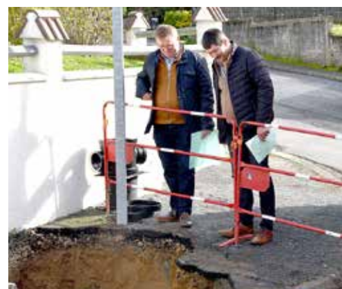
Olivier Vitré (à g.) et Dominique Séchet ont pu mesurer l'avancement du chantier.
