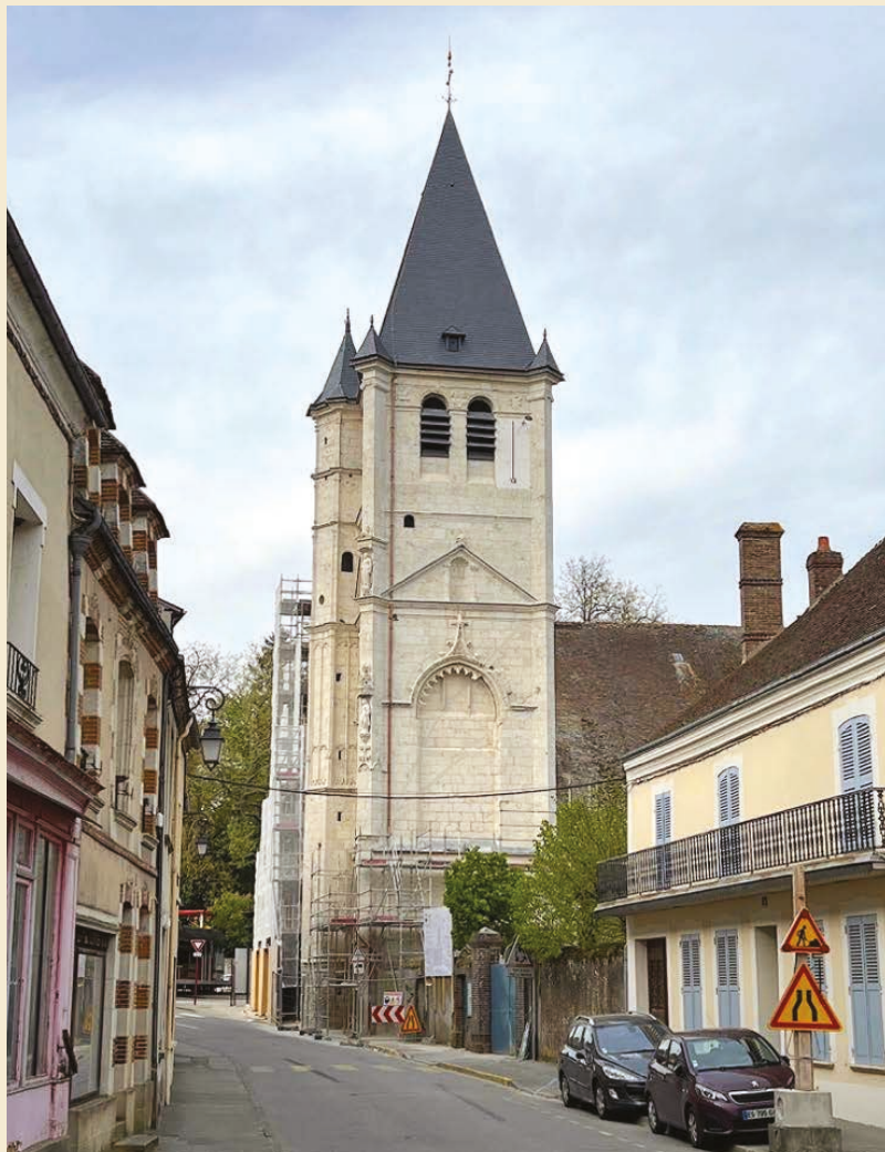
Vue générale du clocher après restauration (photo avril 2022)
