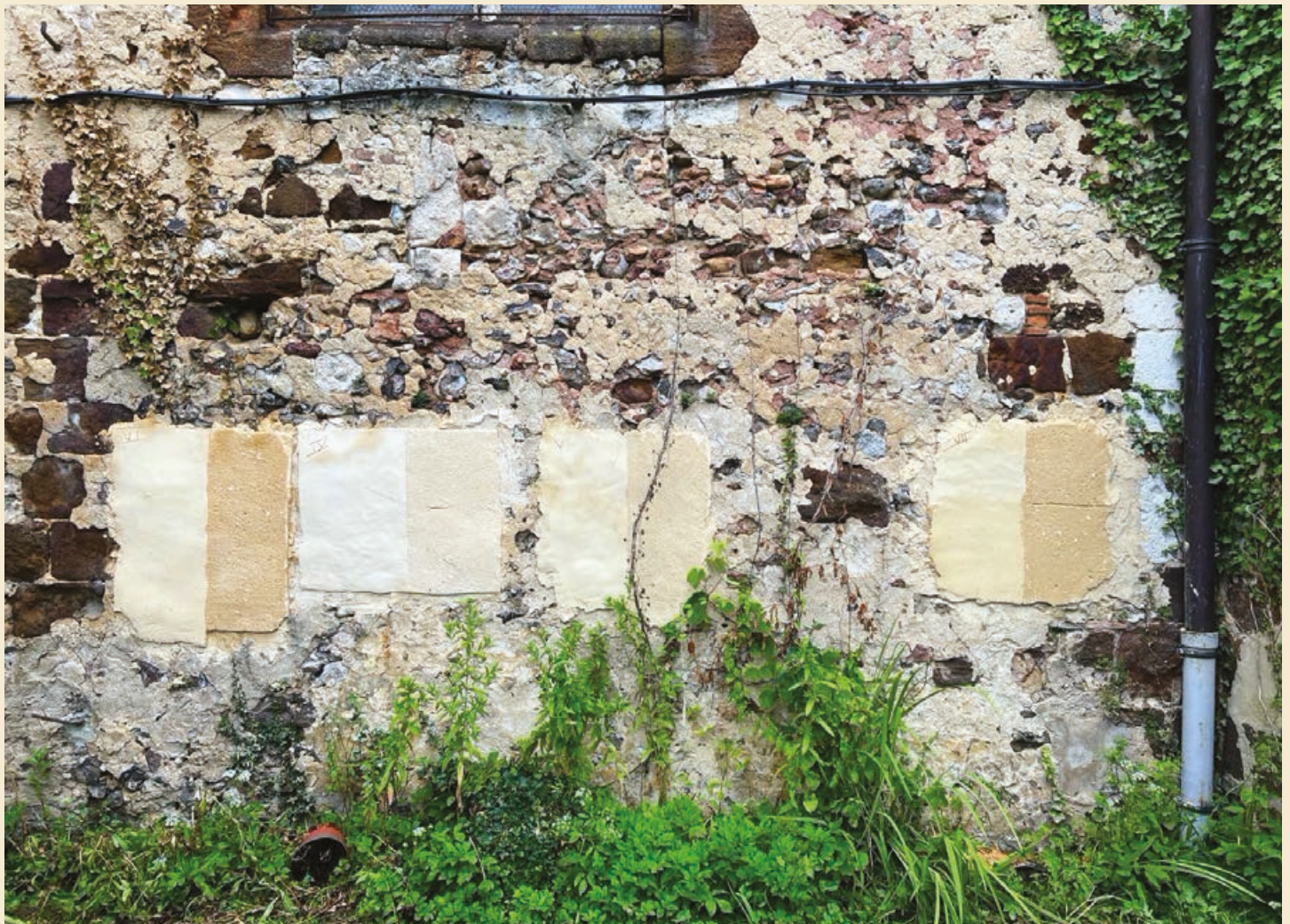
Vue générale des essais d'enduits neufs réalisés sur la façade Sud du chœur, avec plusieurs aspects de finition (lissé, gratté, etc.). L'échantillon de droite a été validé pour l'ensemble de l'édifice.
