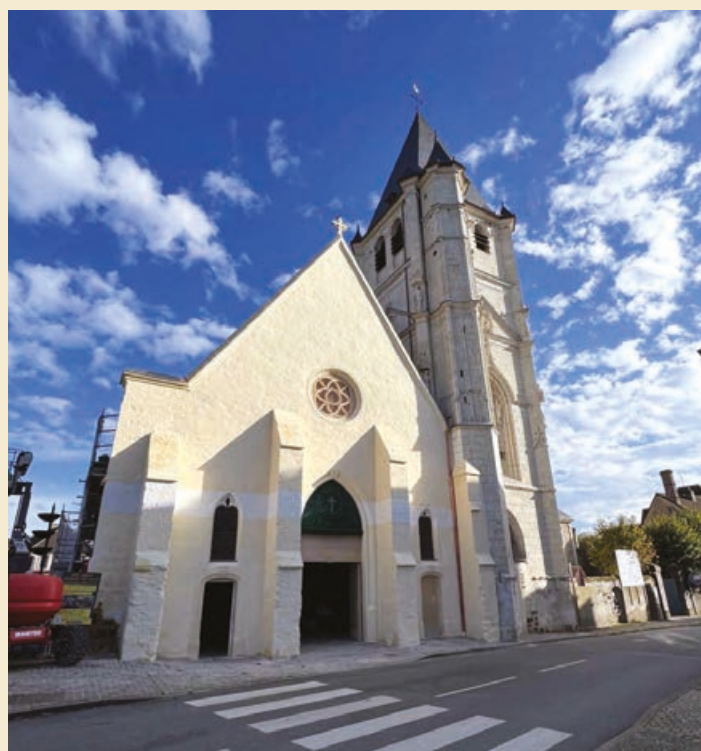
Travaux en cours (2022) – Restitution du ton pierre.
