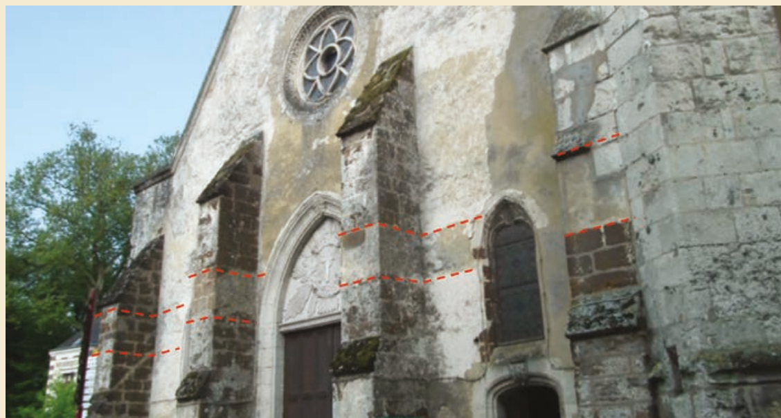
Photo façade occidentale avant travaux (2019). En rouge, la délimita- tion des vestiges de la litre seigneuriale.
