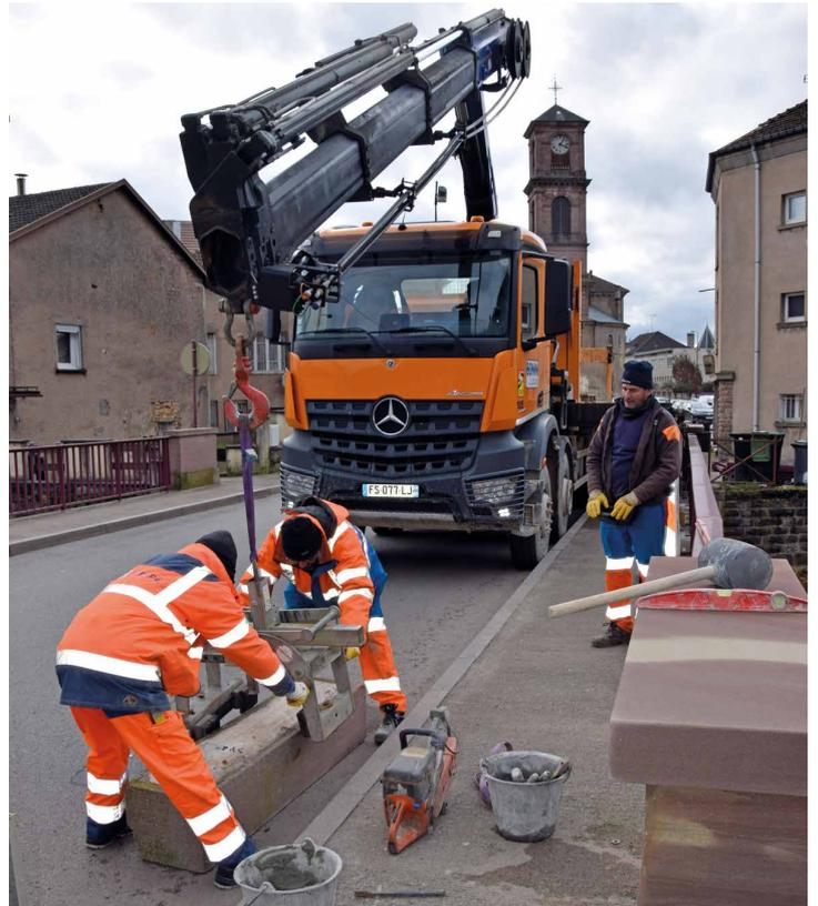
**PONT NEUF** : le 1<sup>er</sup> mars, l'entreprise Bonini de Vincey (88) a remplacé deux piles en grès rose de part et d'autre du pont sur la Plaine, ainsi que plusieurs éléments de la rambarde qui étaient abîmés. Ces travaux sont réalisés pour le compte du Conseil Départemental des Vosges.
